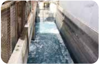
中國常州寶萊污水處理站
